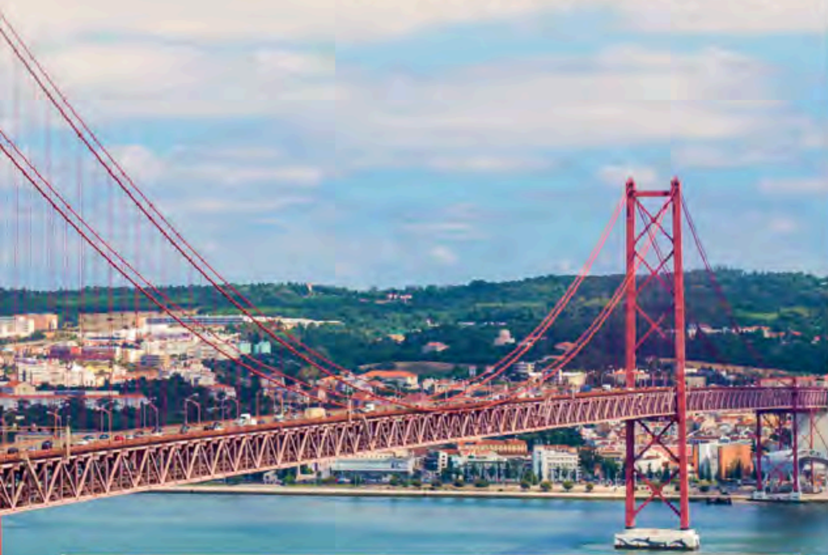
The 25 de Abril Bridge, Lisbon
